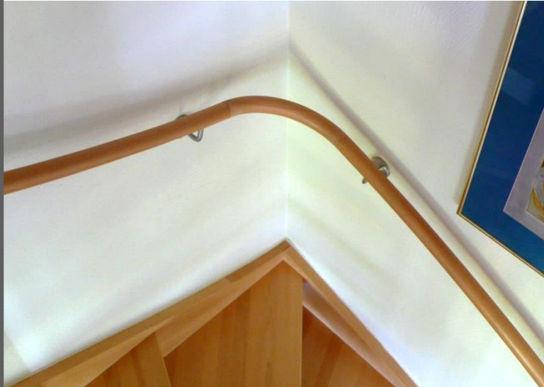
Verlauf über Eckbogen RA 242mm durchlaufend
