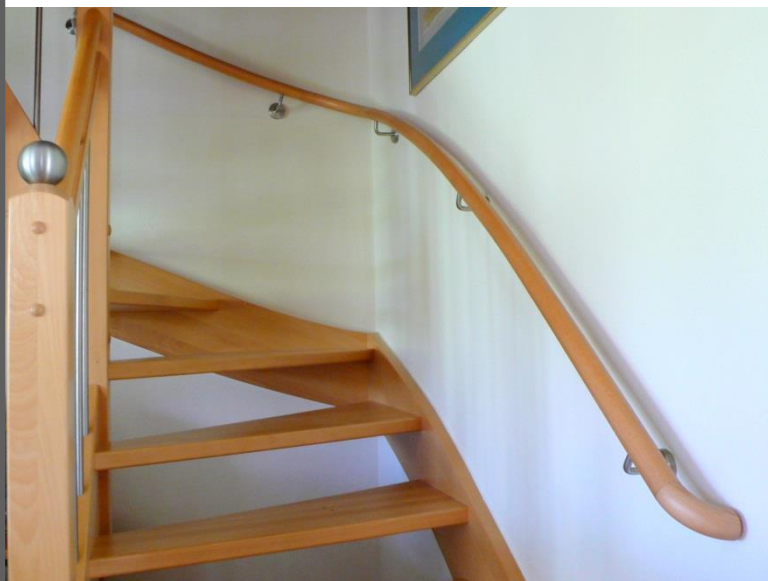
Anfang mit 90° Endbogen zur Wand geführt
